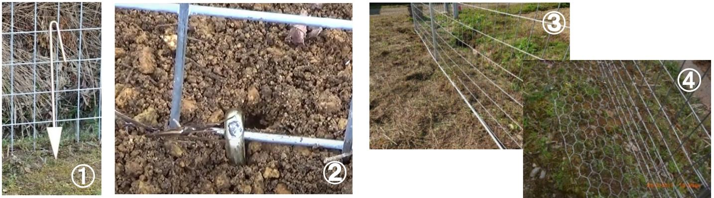
【標準仕様】 被害程度も様々なことから過度な対策でコストが高まれないよう、メッシュ埋め込み (標準75mm) + アンカーピンでの固定を標準採用 (写真①②) **いのガード・しかガード・さるガードすべてで採用**
